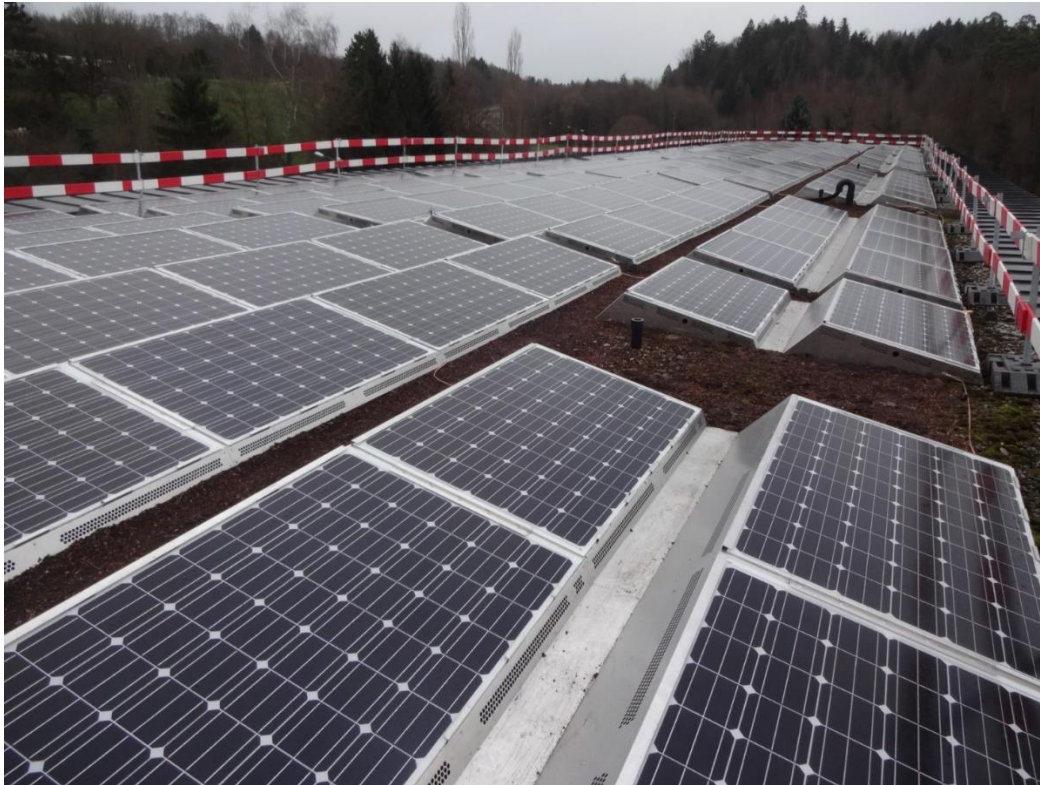
Die neue Photovoltaikanlage auf dem Dach des Hauptgebäudes soll bis zu 90 kWp leisten.
