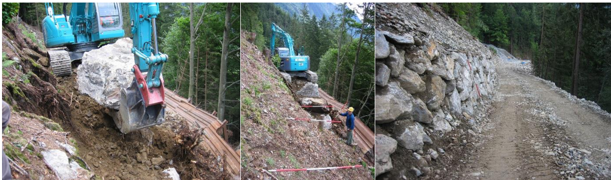
Protection et dimensionnement : chantier de route forestière à Silenen (UR). Photographies F. Ferrario
